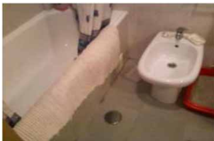
Figura 2. Casa de banho antes da intervenção da Oficina Social.
